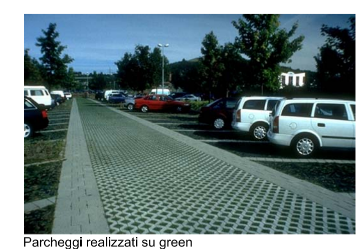
Parcheggi realizzati su green
