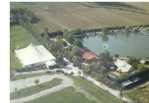
Foto dello stato attuale
