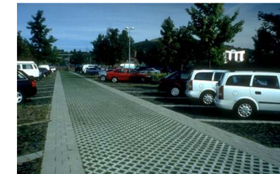
Parcheggio realizzato su green
