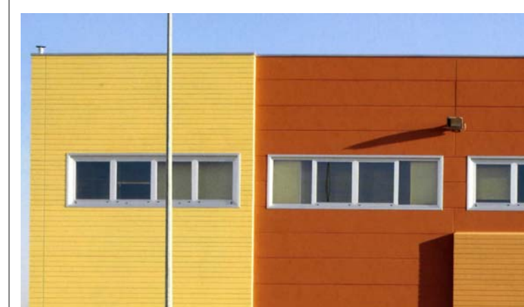
Edificio in pannelli prefabbricati
