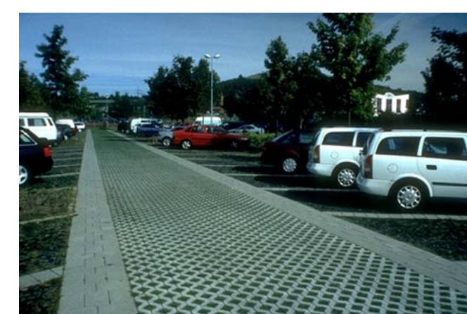
Parcheggio realizzato su green
